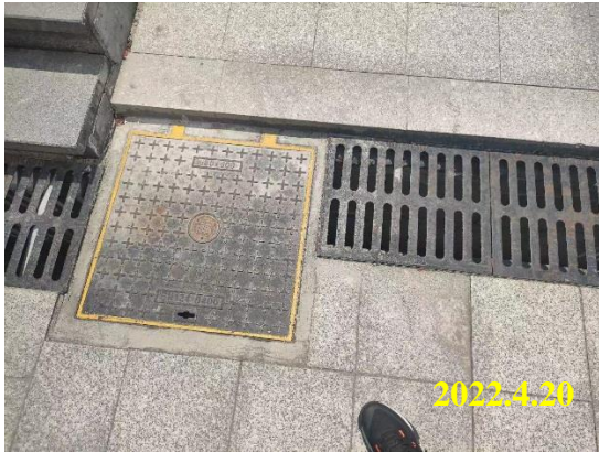
项目雨水井盖
