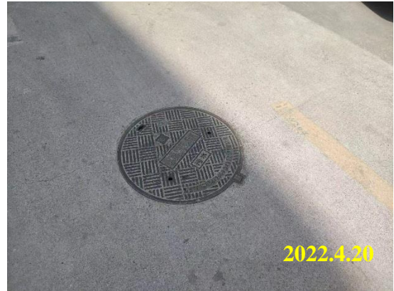
项目污水井盖
