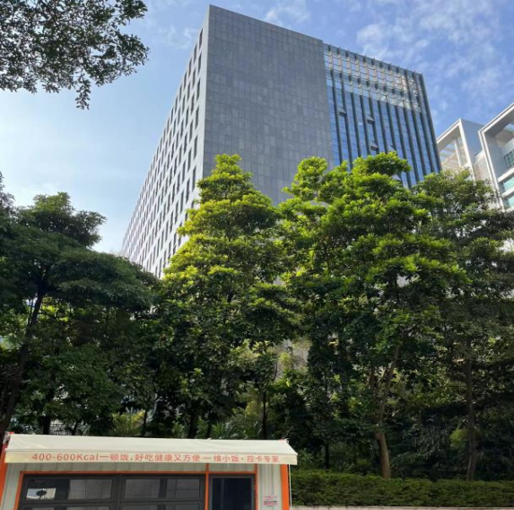
项目西面为大族创新大厦 C 座
